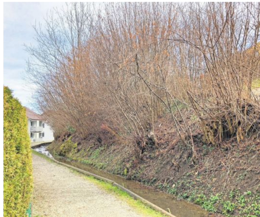
Derzeit finden an der Hecke am Mülibach Rückschnittarbeiten statt. Fotos Ramon Juchli
